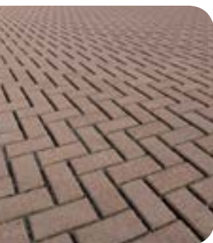
Foto | Straatstenen in keperverband
