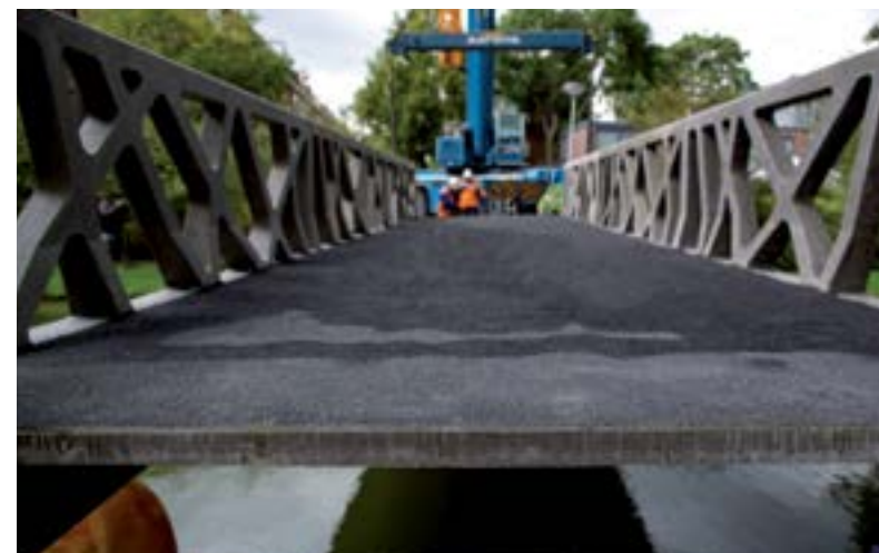
Foto | Door het gebruik van UHSB heeft deze brug in Rotterdam een lage CO 2 -footprint. Foto: Peter Buitelaar.
