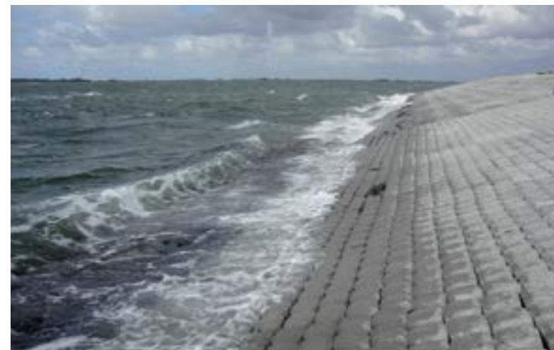
Foto | Slim vormgegeven dijk-bekleding met 30% gewichtreductie
